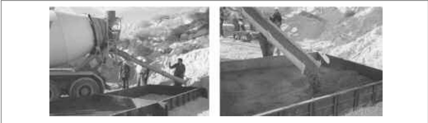
Fig. 10. Elaboración de la losa de hormigón convencional Fig. 10. Elaboration of the slab with conventional concrete
