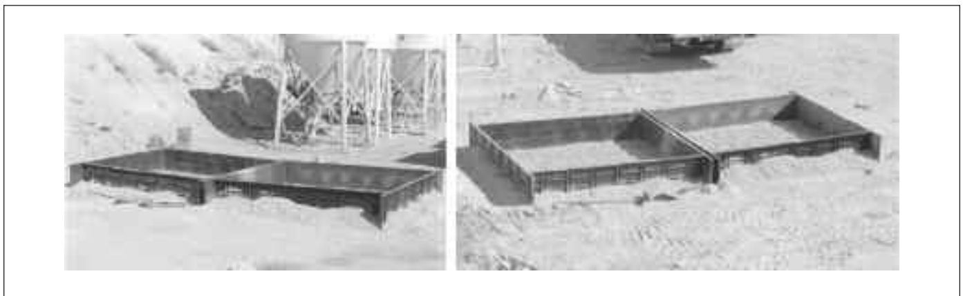
Fig. 7. Encofrado de las losas Fig. 7. Timbered of slabs
