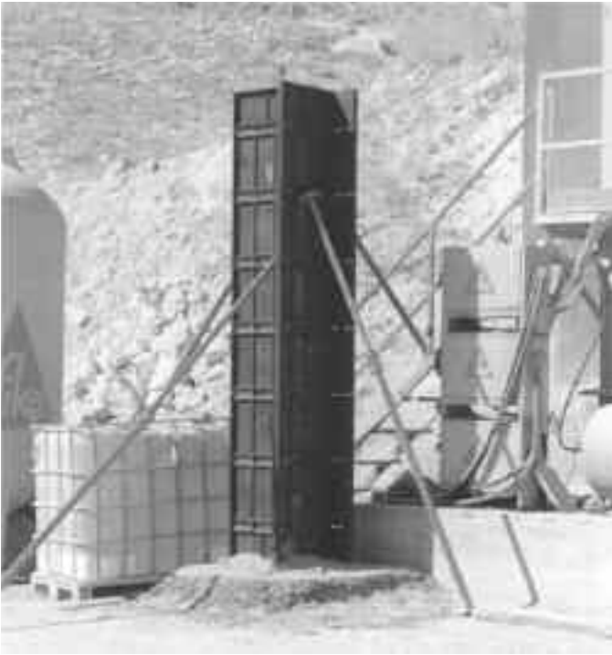
Fig. 8. Encofrado del pilar Fig. 8. Timbered of pillar
